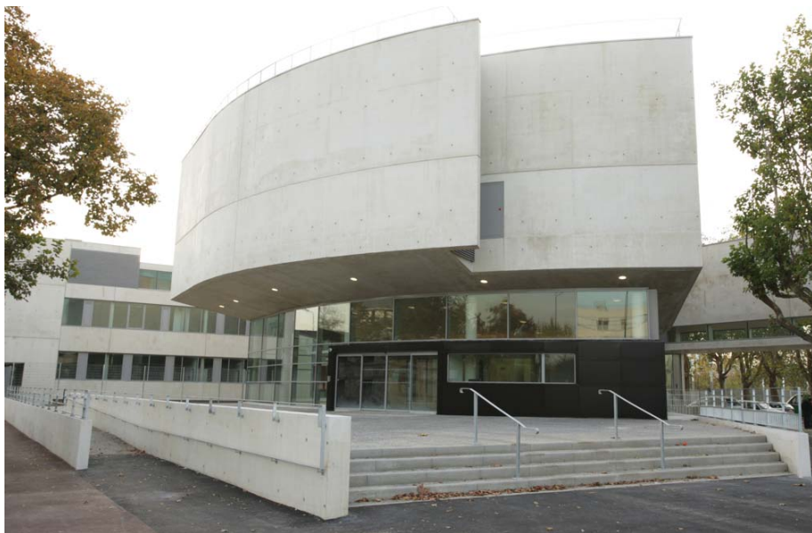
Façade sur entrée
