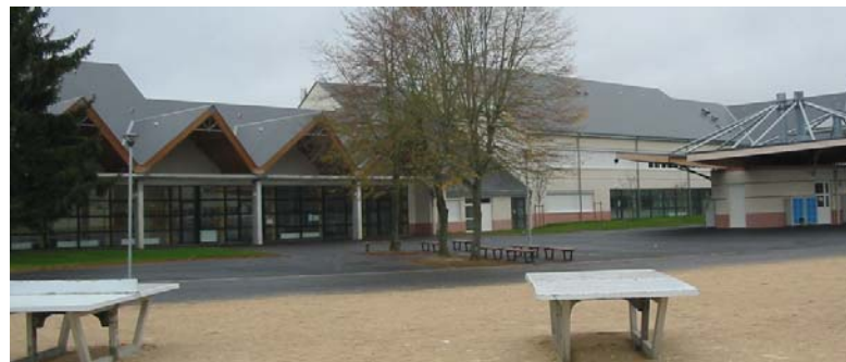
Bâtiment restauration sur cours
